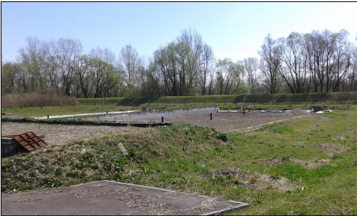
Slika 1.3 Postojeće stanje UPOV-a Jasenovac (slika preuzeta iz Elaborata zaštite okoliša „Izmjena zahvata – uređaj za pročišćavanje otpadnih voda naselja Jasenovac i Spomen područja“, Zeleni servis d.o.o.)
