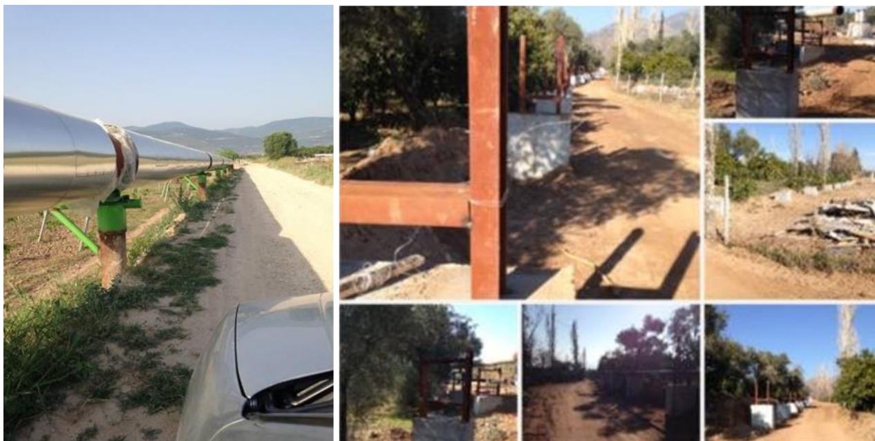
Grafički prikaz 3-11: Temeljne konstrukcije nadzemnih cjevovoda
