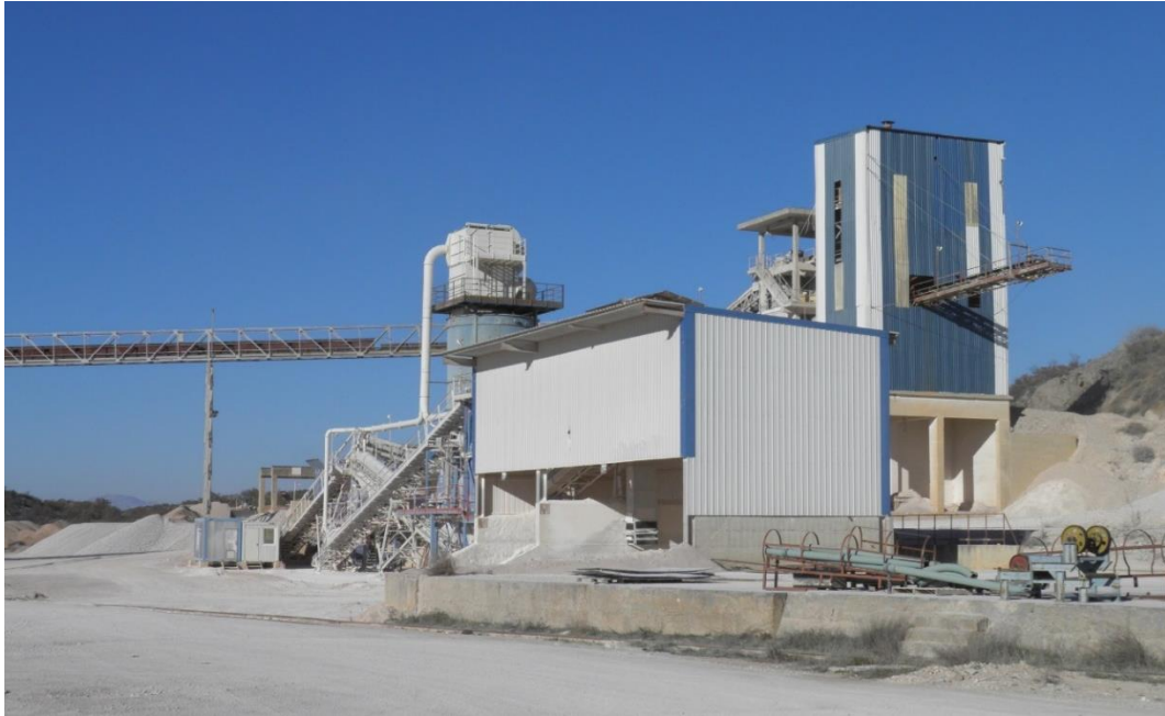
Slika 6. Postojeće stacionarno oplemenjivačko postrojenje
