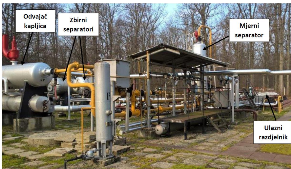
Slika 1.5.2. Tipska mjerna stanica na EPU Žutica
