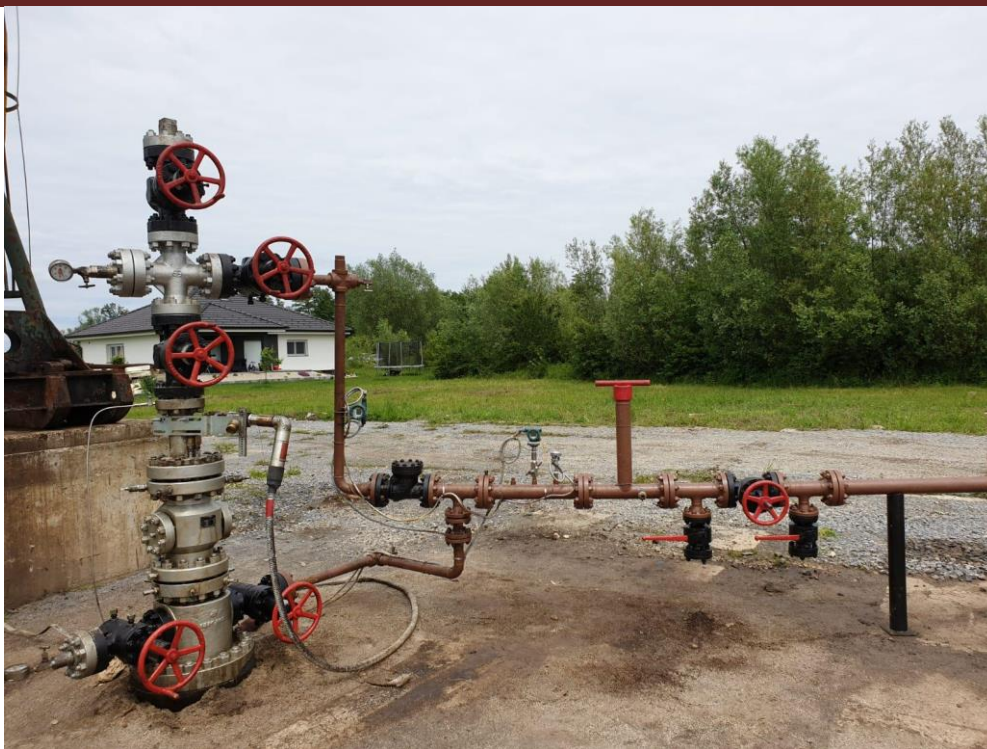
Slika 1.4.15. Naftna bušotina s uronjenom centrifugalnom sisaljkom Žu-8
