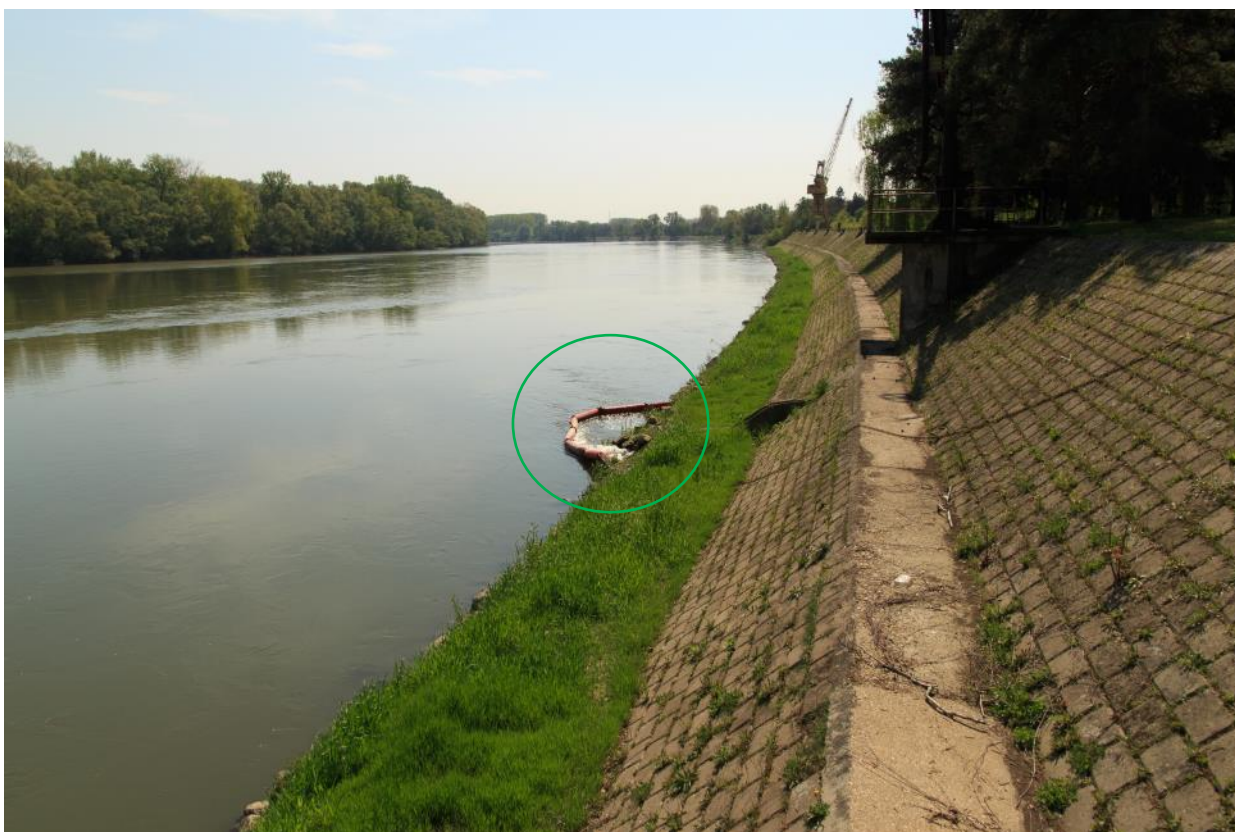
Sl. 5.2-2: Postojeće stanje lokacije ispusta rashladne vode u rijeku Dravu
