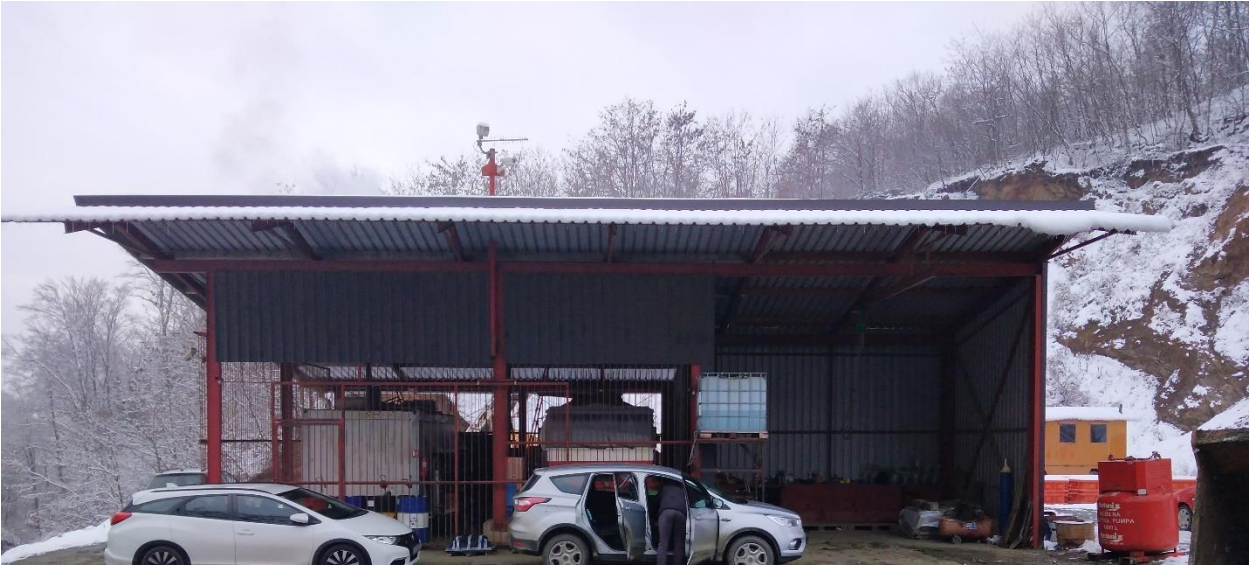
Slika 5. Postojeće stanje – plato za pretakanje goriva (s nadstrešnicom, asfaltirana podloga) i objekt (kućica) za zaposlene
