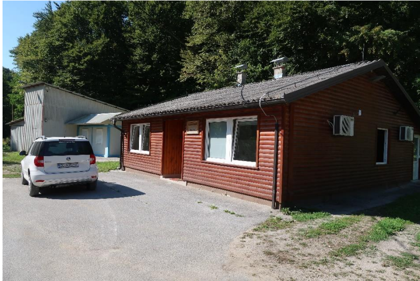
Slika 10. Objekt za smještaj radnika i nadzornog osoblja
